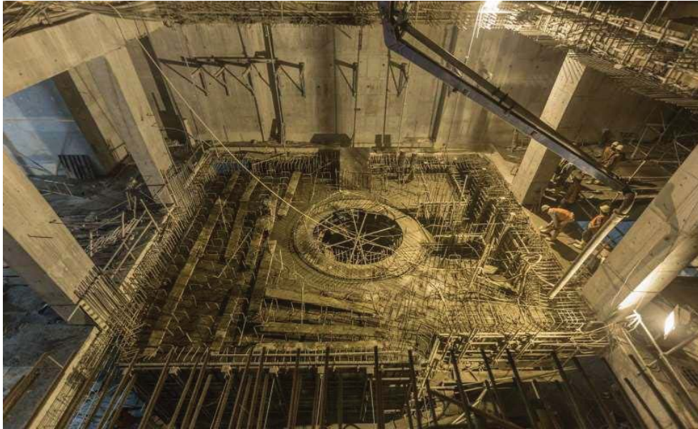
බිම් මට්ටමේ සිට කිලෝ මීටරයක් ගැඹුරින් ඉදිකරනු ලබන භූගත ජල විදුලි බලාගාරයේ ඉදිකිරීම්
