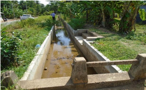
குளிக்குமிடங்களுடன் கூடியதாக நீர்ப்பாசனக் கால்வாயைக் கொங்கிரீட் இட்டு மூடுதல்
